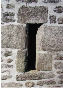
Fenêtre-meurtrière de la grange, côté Est. (Cliché V. Le Floc'h)
