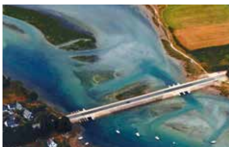
Le Ster après les travaux
