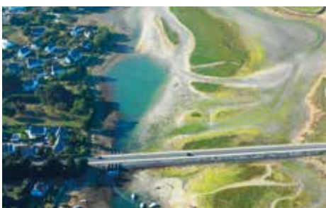
Le Ster avant les travaux
