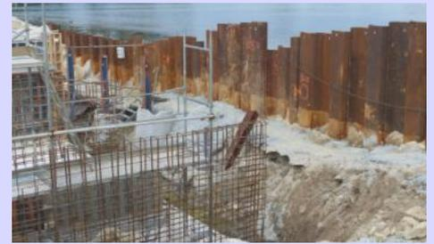
Sur le coté Est de Larvor, la roche n'était pas présente sous toute la largeur de l'ouverture prévue. Il a donc été nécessaire de la décaler vers l'est afin de trouver une bonne assise au radier. Ceci a nécessité l'arasement de la tête de roche, le démontage et le remontage de la grue, l'allongement des poutrelles IPN, supports des réseaux, et un terrassement supplémentaire.
