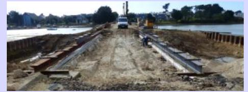
Coté Ouest Lesconil : l'eau du ster s'écoule sous le radier existant où le flot a créé des canaux. Le coulage du radier de l'extension sera donc plus complexe.
